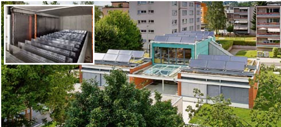
In diesem Kindergarten in Rapperswil wird im unterirdischen Eisspeicher Sonnenenergie gebunkert. HSR
